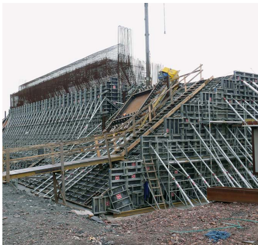
➔ Wiadukt WD 464. Deskowanie przyczółka – wezłowa łuku
