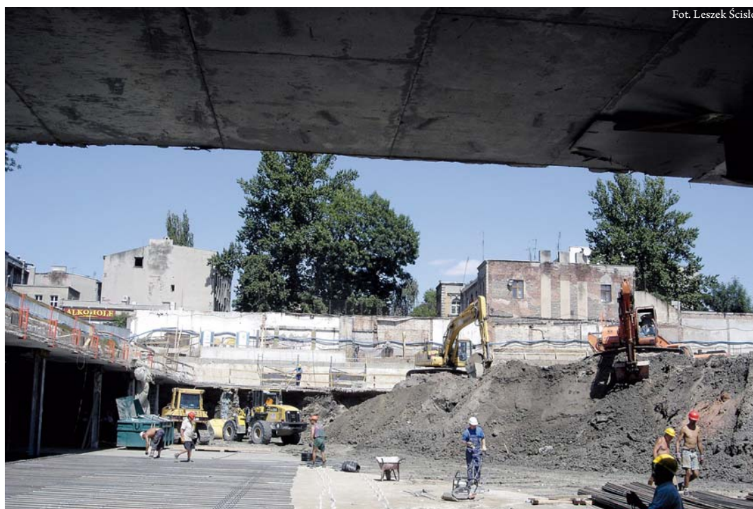
→ Budowa biurowca w Łodzi. Wykop pod garaż dwupoziomowy realizowany metodą górniczą
