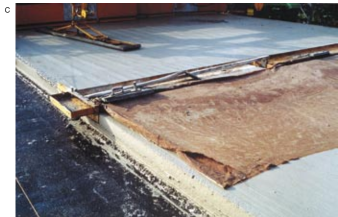
Rys. 6.4. Technologie wykańczania nawierzchni: a, b) szczotkowanie, c) zacieranie jutą
