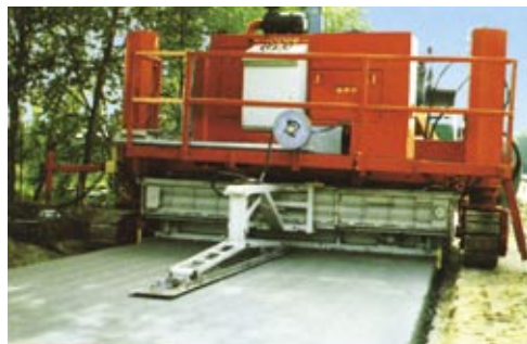
Rys. 6.1. Transport mieszanki i układanie nawierzchni w deskowaniu ślizgowym
